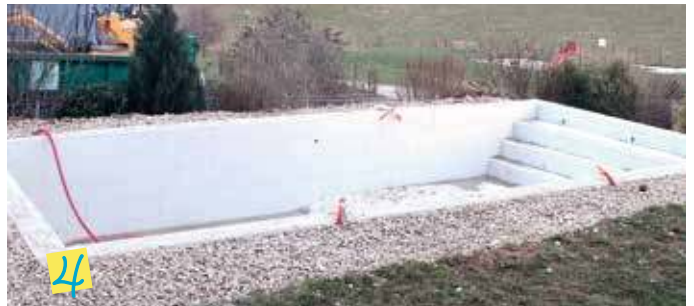
4 Relleno, alisado, colocación del carril y colocación del borde.
