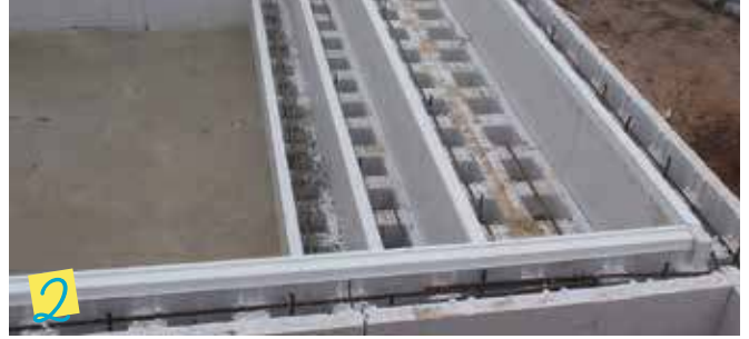
2 Montaje de los bloques y estructura.
