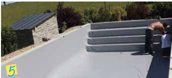
5 Colocación del fieltro y el revestimiento.
