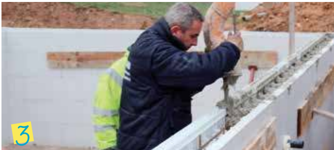
3 Vertido del hormigón.
