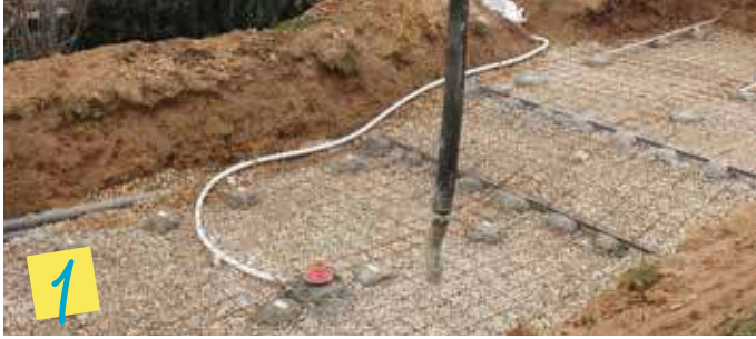
1 Movimiento de tierras, armaduras y hormigón de fondo.
